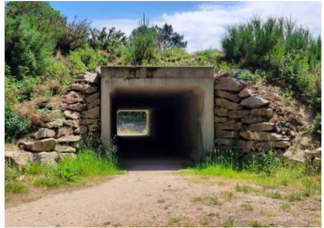
PIGR sous faible remblai
