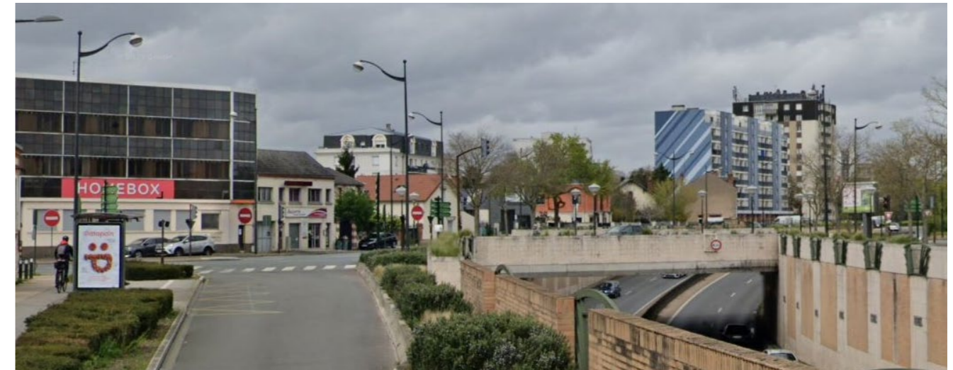
Figure 30 : Carrefour dénivelé RD2020-RD951 à Orléans (Google maps)
