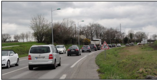
Section Ménimur – Trois Rois (photo INGEROP)
