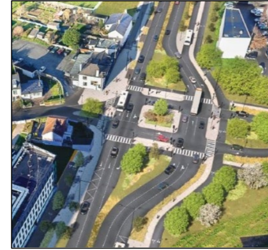
Figure 28 : Place à feux sur la RD177 – avenue Dodin, au Sud de la rocade de Rennes (Google Earth)
