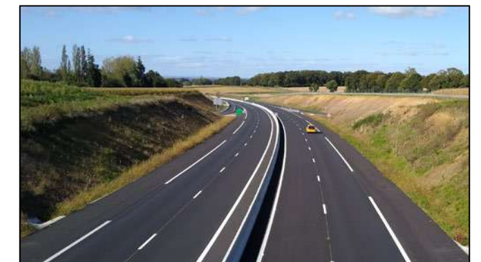
RD767 au droit du nouvel échangeur de Moréac (photo INGEROP)
