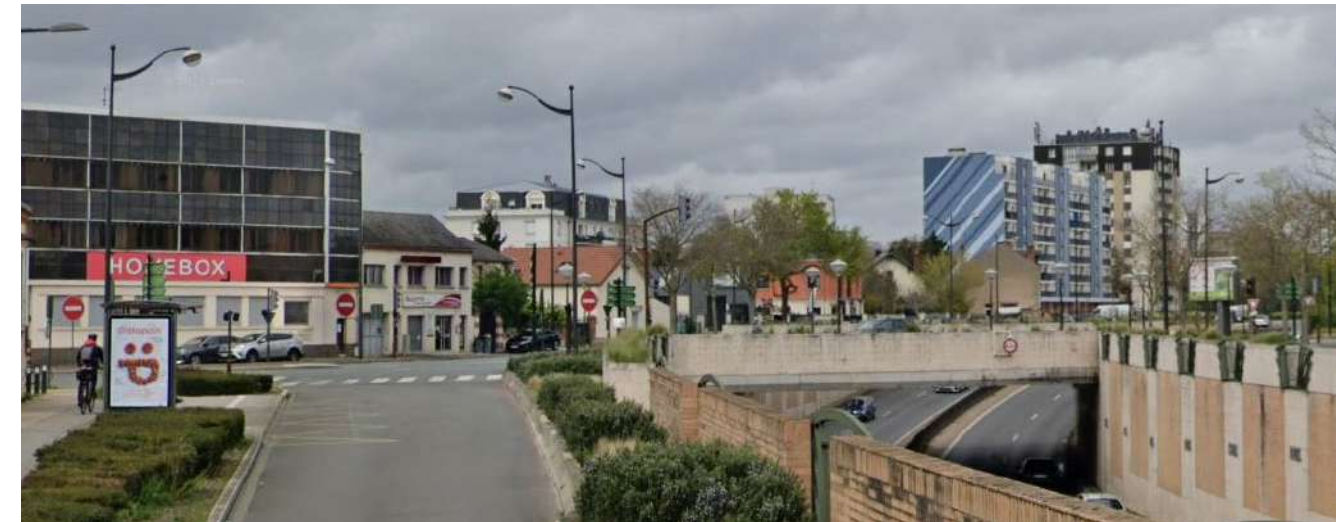
Figure 30 : Carrefour dénivelé RD2020-RD951 à Orléans (Google maps)
