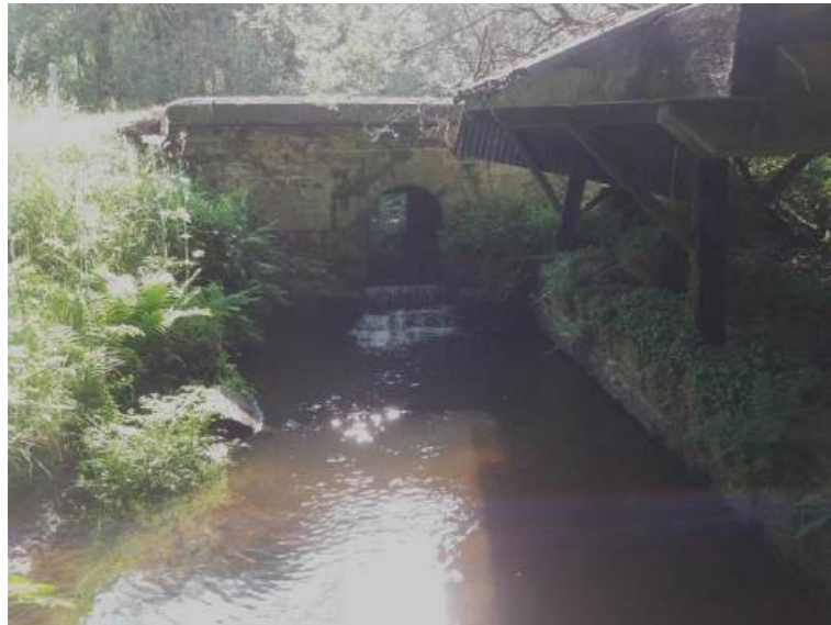
Photo 2 : OH2 (1,00 x 1,20) sous la RD 782
