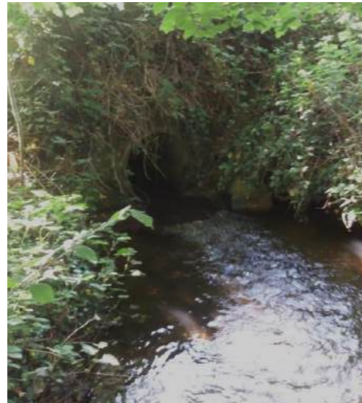
Photo 3 : OH3 (Ø 600) sous voie communale
