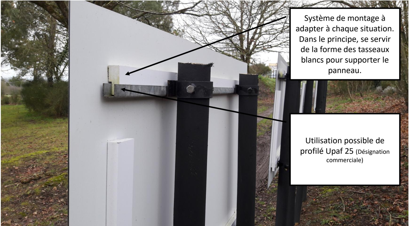
Système de montage à adapter à chaque situation. Dans le principe, se servir de la forme des tasseaux blancs pour supporter le panneau.
